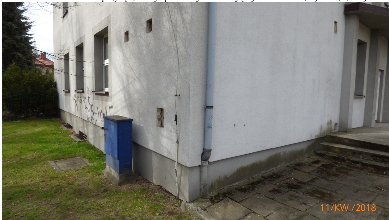
Widok 3- Widok na przyłącze rury spustowej do istniejącej sieci kanalizacji deszczowej
