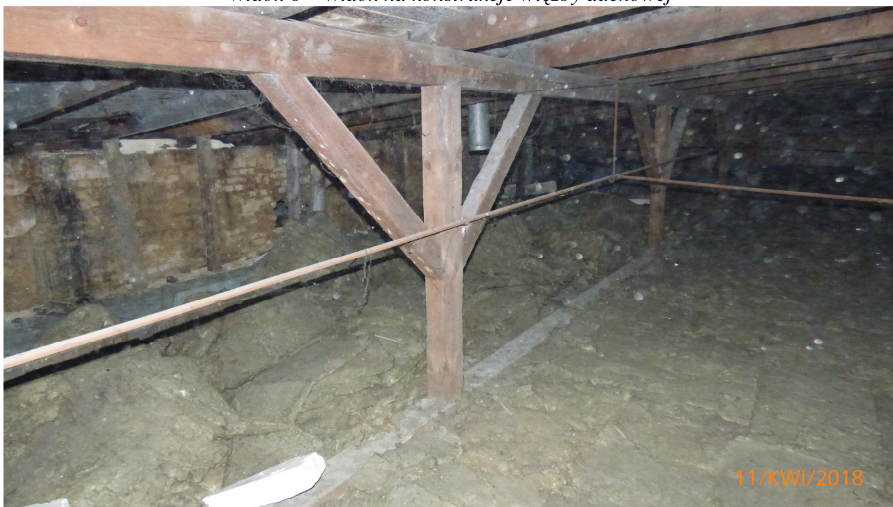
Widok 8 – Widok na konstrukcję więźby dachowej
