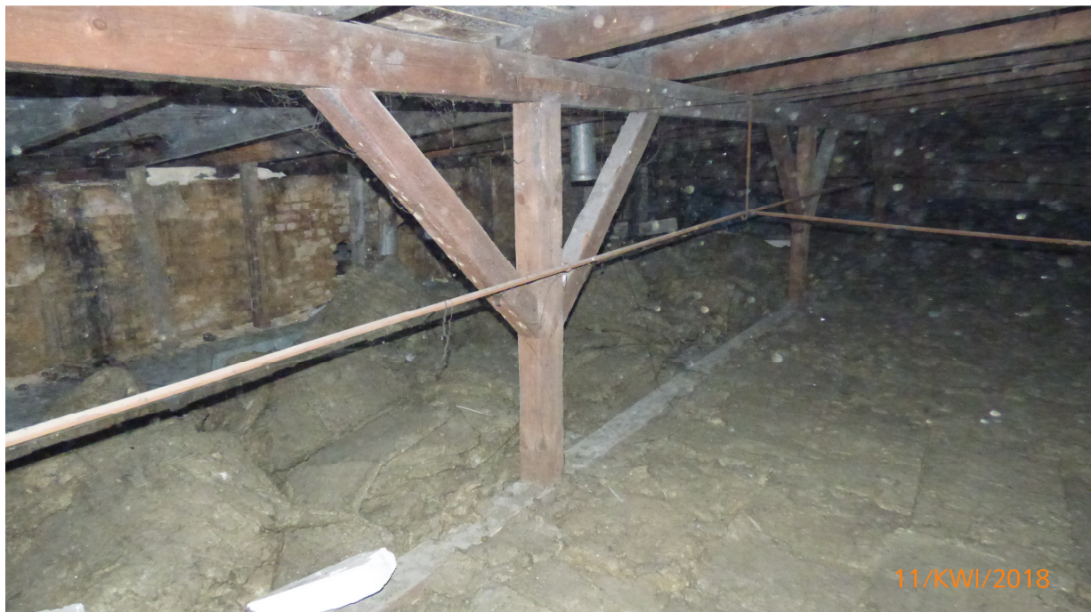
Fot.2. Widok na płatew podpartą rzędem słupów, w tle ściana kolankowa.
