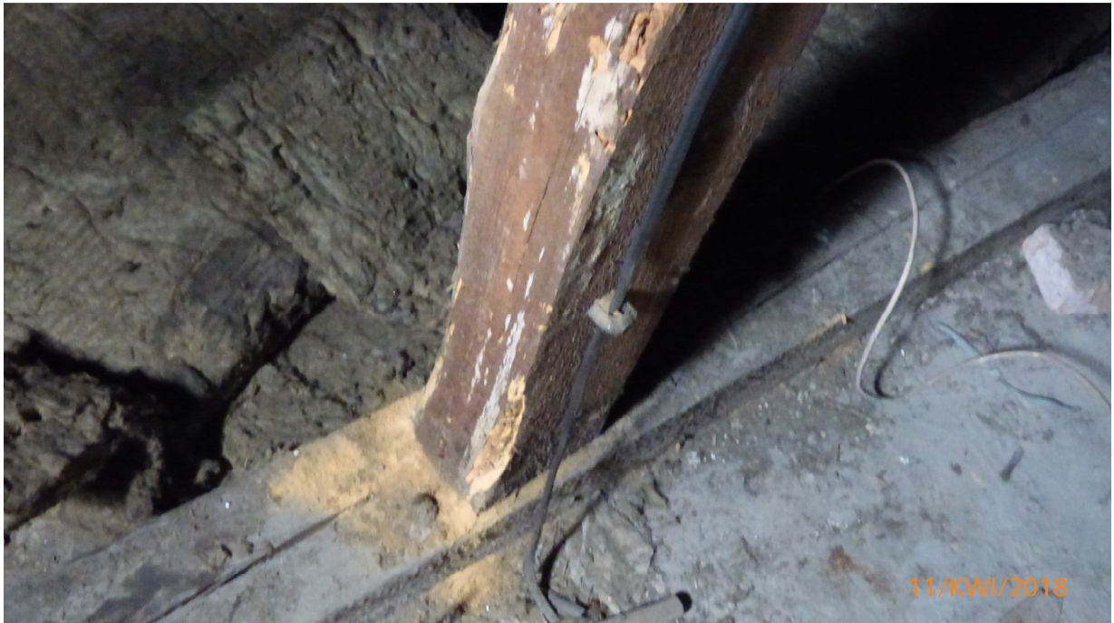
Fot.3. Widok na połączenie słup – belka podwalinowa.
