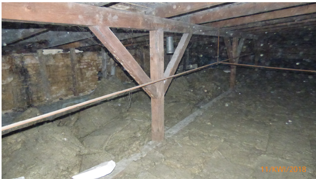
Fot.2. Widok na płatew podpartą rzędem słupów, w tle ściana kolankowa.
