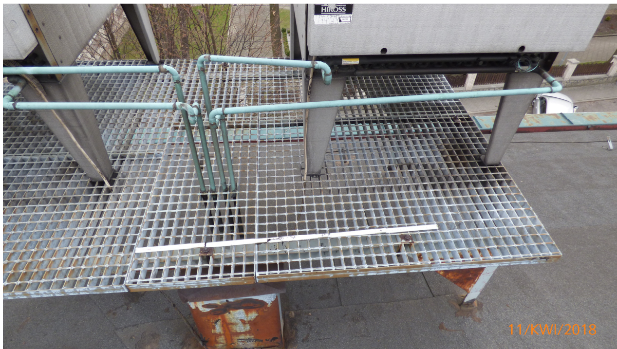
Widok 5- Widok na stalową konstrukcję wsporczą na dachu – do zachowania
