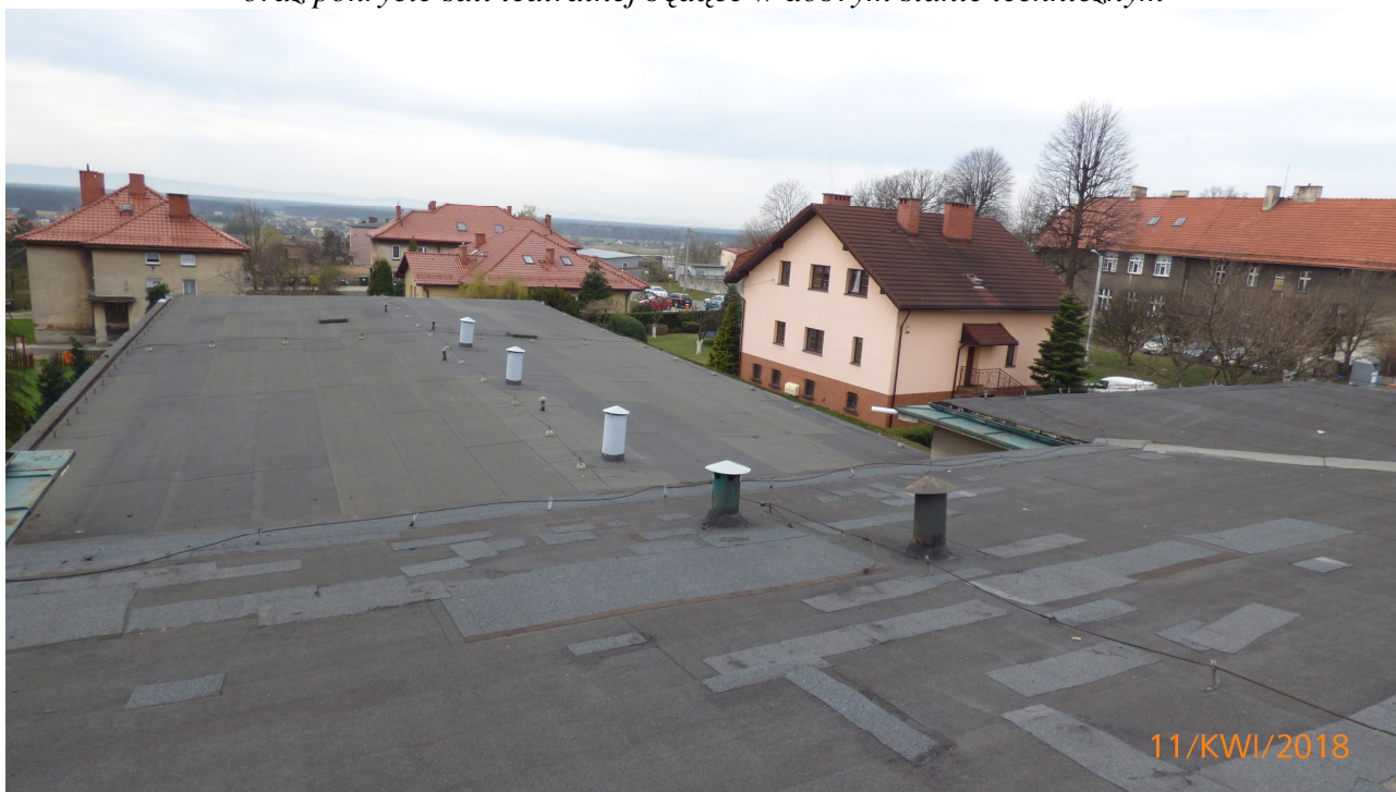
Widok 6- widok na pokrycie budynku objętego zakresem opracowania (w złym stanie technicznym) oraz pokrycie sali teatralnej będące w dobrym stanie technicznym
