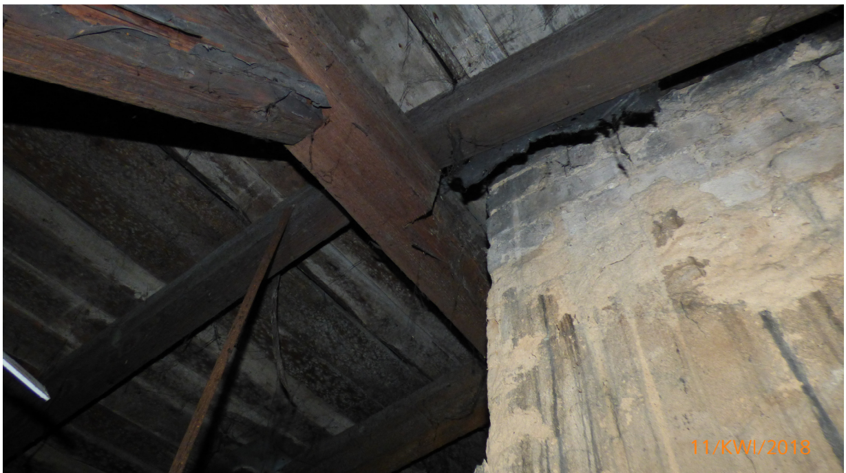
Fot.4. Widok na oparcie krokwi na płatwi kalenicowej – widoczne pęknięcie płatwi, źle wykonana obróbka komina, czego efektem są widoczne zacieki na pozostałościach tynku w obrębie komina.
