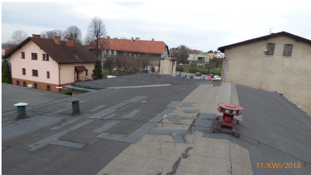
Fot.5. Widok na stan pokrycia więźby dachowej oraz obróbek blacharskich.
